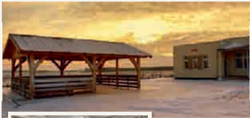
Świetlica wiejska – 2020 r.
