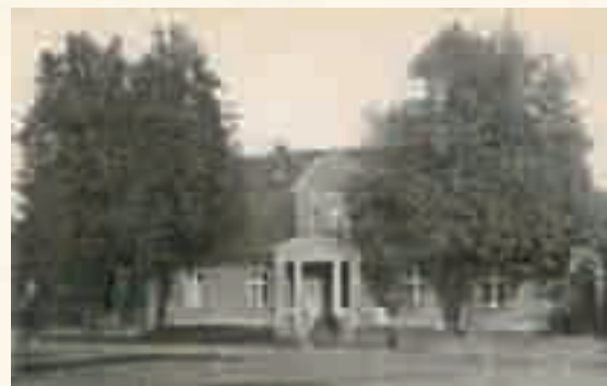
Dwór wyburzony w latach 70. XX wieku
