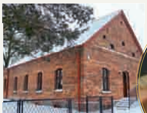
Budynek starej plebanii – obecnie Dzienny Dom Pobytu
